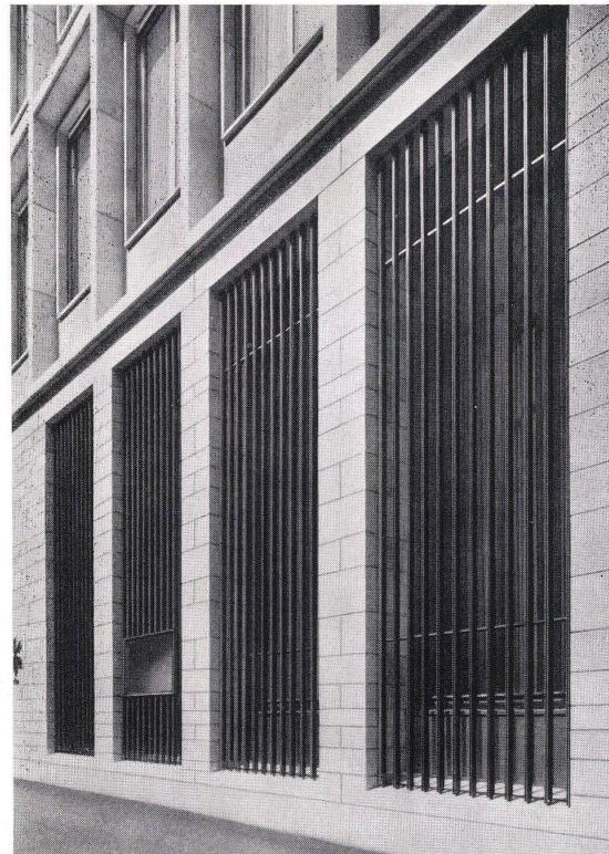
Die 4,2 m hohen Fenstergitter mit eingebauten Schaukästen. Gitter und Vitrinen-Rahmen sind aus stranggepreßten Bronze-Profilen zusammenggebaut.
