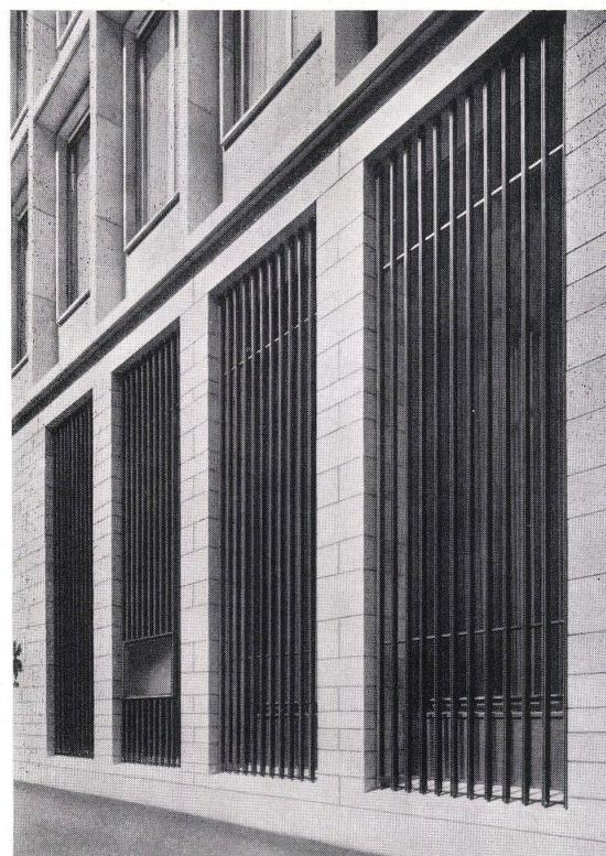
Die 4,2 m hohen Fenstergitter mit eingebauten Schaukästen. Gitter und Vitrinen-Rahmen sind aus stranggepreßten Bronze-Profilen zusammengesetzt.
