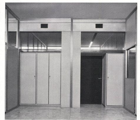
Details der Korridorwand eines Büros mit Zuluftöffnungen, Oberlichtstreifen und Profilschienen für Zwischenwände. Détails de la paroi du couloir d'un bureau. Detail of the corridor wall of an office.
