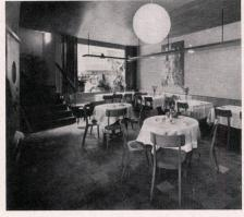
Innenansicht des Bierrestaurants im Erdgeschoß mit Mosaik von E. Häfelfinger. Decke aus Holzlamellen, zwischen denen Frischluft eintritt und verbrauchte Luft abgesaugt wird.
