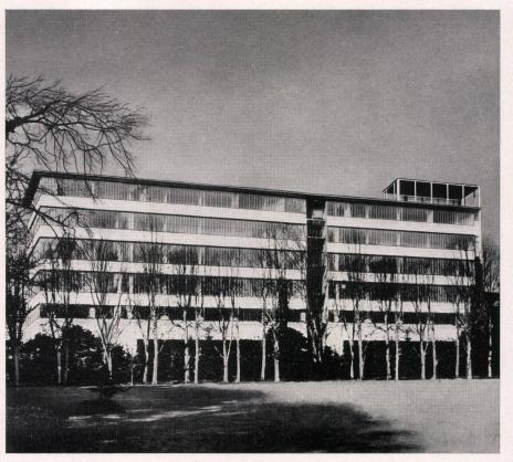
Betriebsgebäude, Bau 27, links Neubau, rechts Altbau von Prof. O. R. Salvisberg, erstellt 1938. Fassaden in Sichtbeton mit doppelt verglasten Stahlfenstern. Bâtiment d'exploitation.
