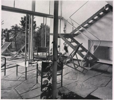
gen oben durch eine Balkonplatte abgedeckt wird, auf welche die Außentreppe aus einem der Schlafzimmer führt. Das Geländer dieser Treppe ist als Sprossenwand, welche über ein ganzes Geschoß geführt wird, ausgebildet. Eine schlanke Stahlsäule führt von der Ecke des Dachbalkons bis hinab auf die Sitzterrasse vor dem Wohnzimmer
