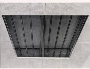
Schallschluckdecke mit Soundex-Platten in einer Weberei (Shedkonstruktion)
