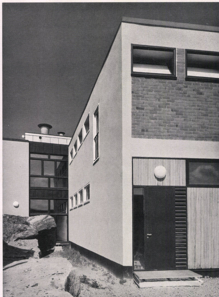
1 Neuer Eingang mit Windfang. Schreinerarbeit schwarz gebeiztes Eichenholz, Wände: roter Backstein. Boden: graue Plastikplatten. Natur-Deckenputz. Nouvelle entrée avec tambour. New entrance with porch.
