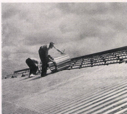
Links / A gauche / Left: Eindecken des Daches. Abrollen der Fural-Bahnen. Pose de la toiture. Déroulement des bandes de Fural. Roof covering. Rolling of Fural strips.
