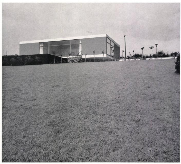
überliegend auskragen. Als Untergrund für den Fußboden des Wohngeschosses und für das Dach dienen quadratische Betonplatten, die auf zwischen die Stahlkonstruktion geschweißte Blechträger aufgelegt sind. Beide Decken, diejenige unter und diejenige über dem Wohngeschoß, sind nach außen mit einem Stahlblechstreifen, der entweder durch ein U-36 oder ein NPN-36 verstärkt ist, abgeschlossen. Zwischen die Flanschen dieser Träger ist zur Isolierung Steinwolle geklebt.
