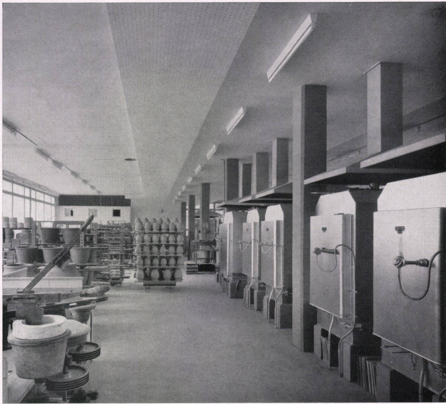
1 Fabrikationssaal im ersten Obergeschoß, Teilansicht mit der Dreherei und den elektrischen Kammeröfen. Salle de fabrication. Production hall.
