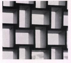
Detail eines Küchengitters aus speziell konstruierten Ziegel-Hohlblocksteinen.
