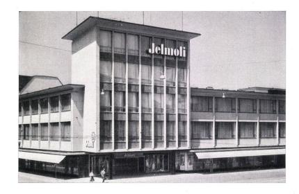
et d'une profondeur de 4,60 m ( $\pm$  0,40 m pour un placard à dossiers). Trois bureaux de 2,80 x 3,80 m, placés de travers, s'avancent vers le nord et vers le sud. La construction portante est une combinai-son de squelettes en béton armé et en acier. Les supports intérieurs et les sous-poutres sont en béton armé; les supports extérieurs en acier agissent comme des appuis pendulaires.
