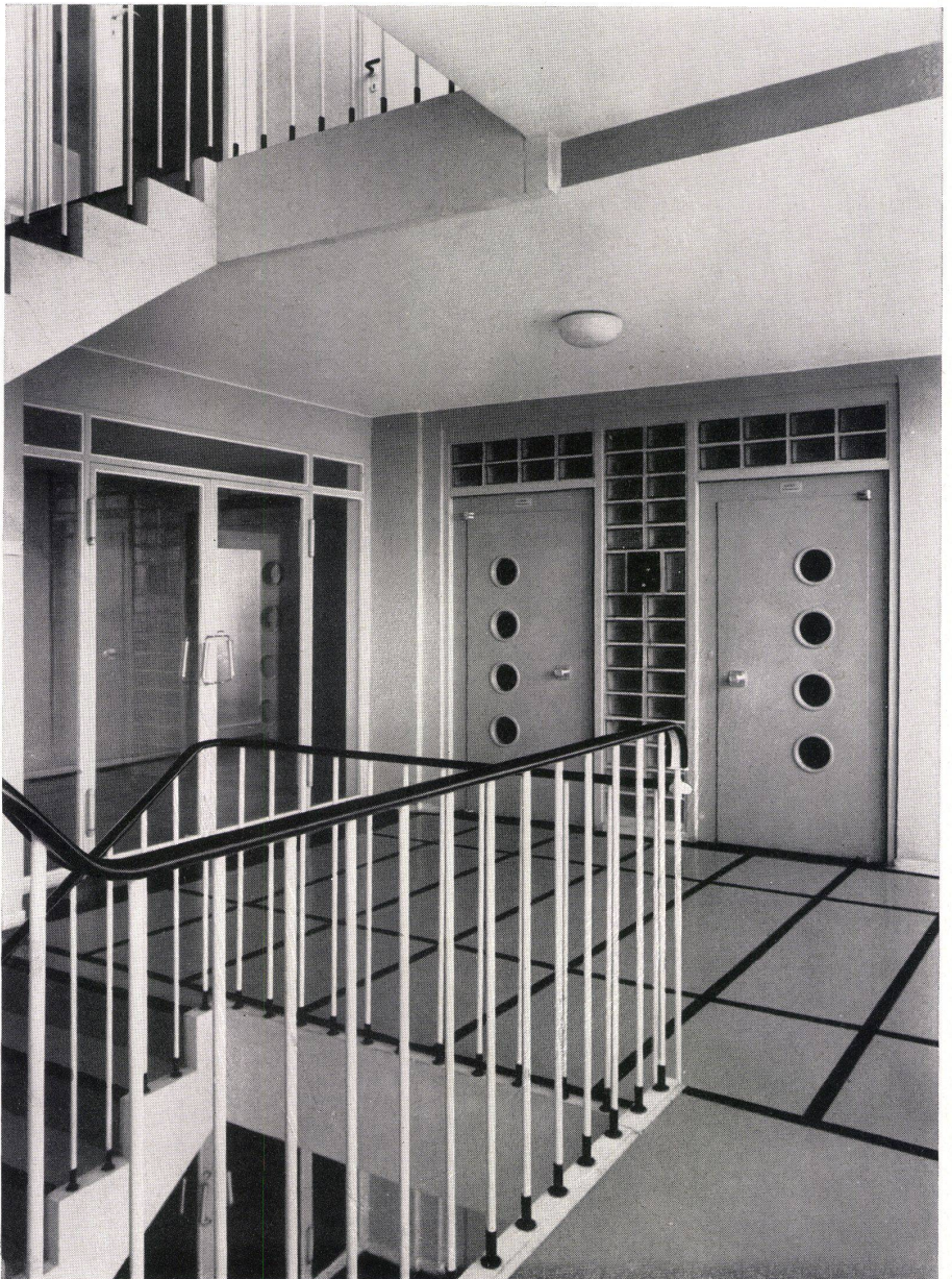
2 Treppe und Podest vor den Aufzügen. Treppe in Kunststein mit Mipolambelag. Escalier et palier devant les ascenseurs. Escalier en pierre artificielle recouverte de Mipolam. Stairs and landing in front of lifts. Stairs in artificial stone with Mipolam flooring.
