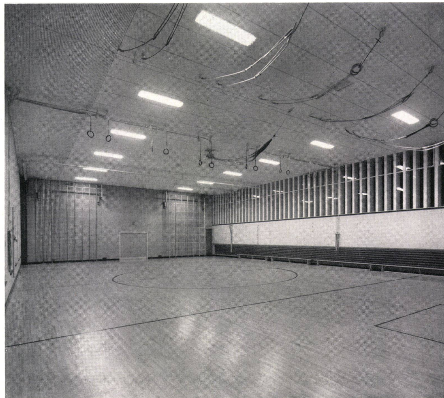
Turnhalle. Beleuchtung mit Fluora-Spezialeinbauleuchten. Leuchten von oben zugänglich, deshalb einfach im Unterhalt. Salle de gymnastique. Gymnasium.
