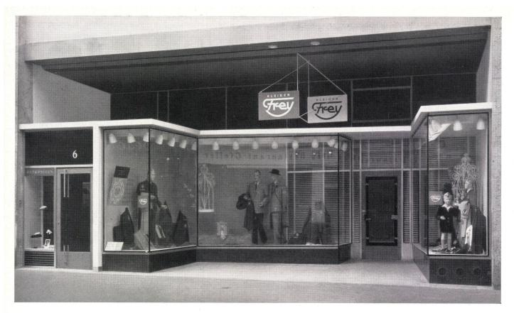
Eingangspartie. Weiß gestrichene Betonkonstruktion. Eisenkonstruktion in schwarzem und weißem Aluminium. Türen Eiche. Sockel schwarze Steinplatten. Reklame nach Entwurf von Alessandro Magoni.
