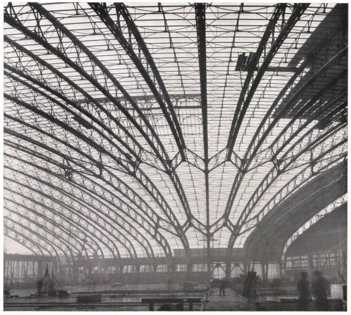
A Ansicht eines Binders von 99 m Spannweite. Rautenfachwerk-Zweigelenk-Binder.
