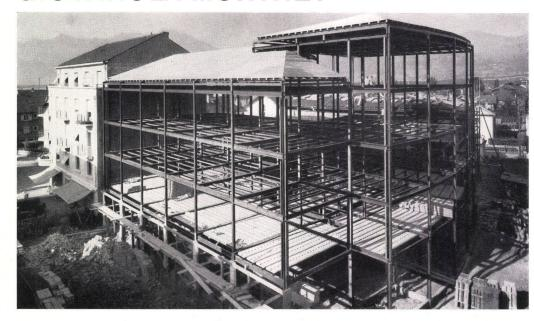
Ossature métallique d'un bâtiment locatif env. 300 tonnes
