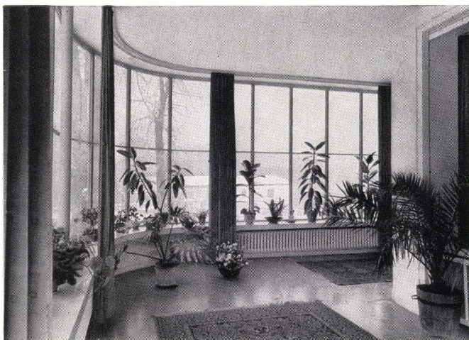
Diese gebogene Fensterwand eines Wintergartens ist mit Cudo-Doppelscheiben verglast, die auch bei hoher Außentemperatur blank bleiben.
