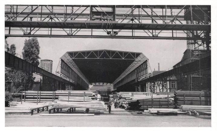
Stahlrohre fanden als Konstruktionselemente schon frühzeitig Anwendung. In größerem Umfang, z. B. als Fachwerk im Hochbau, wurden jedoch Rohrkonstruktionen erst möglich, nachdem die Schweißtechnik ihren heutigen Stand erreicht und ein gut schweißbarer Sonderstahl von hoher Festigkeit sich für diese Konstruktionen bewährt hatte.
