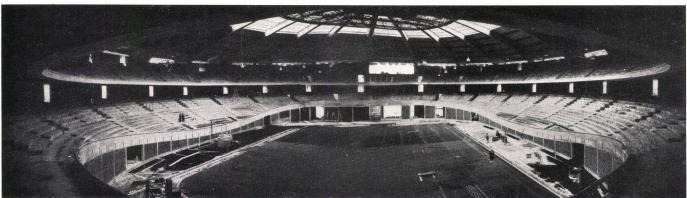
Stahlkonstruktion beträgt etwa 1700 Tonnen; ein einzelner Binder wiegt ungefähr 70 Tonnen. Die äußere Verglasung des Stahlbetonkerns mit 4000 Scheiben zu je 1 qm wird durch die Zuganker der 20 Dachbinder gegliedert. Diese Zuganker sind in den Stahlbetonfundamenten der Halle befestigt.
