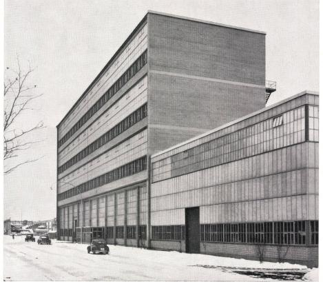
rungsmöglichkeit der gesamten Anlage in östlicher Richtung sind sämtliche Ostfassaden als ausgesprochene »Wachstumswände« leicht demontabel ausgebildet. Umfassungswände der Halle für Nebenbetriebe und Ostfassade, Kessel- und Regulierteil mit äußerer, profilierter Aluminiumblechverkleidung und innerer Durisol-Wärmeisolierung.
