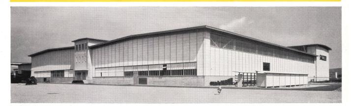
Rohrwerkstatt im Werk Oberwinterthur der Gebr. Sulzer AG., Winterthur Baubüro der Gebrüder Sulzer AG. und Architekten BSA Suter & Suter, Basel Horizontale Durisol-Aussenwandplatten auf Stahlkonstruktion
