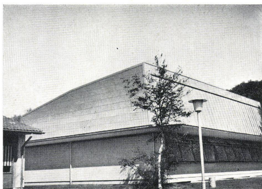
Turnhalle Steigerhübel Bern Dach- und Wandverkleidung in FURAL
