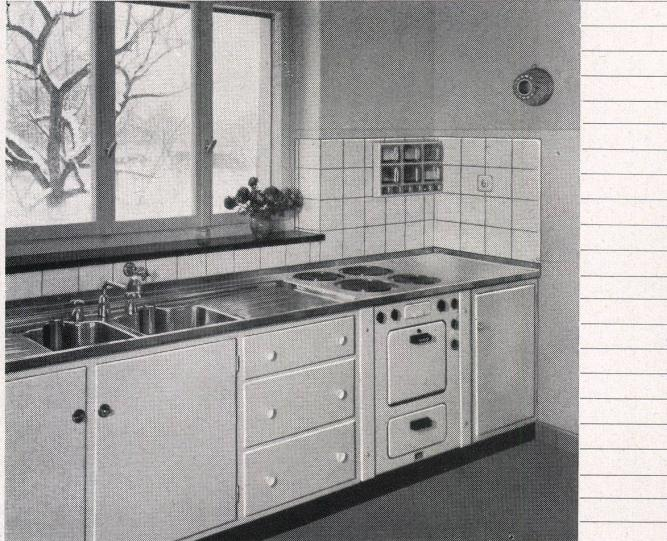
Die neuen ELCALOR-V-Herde sind geradezu ideale Einbau-Modelle: Ihre Vorderwand ist leicht abnehmbar; sämtliche inneren Teile sind nötigenfalls mühelos mit ein paar Handgriffen von vorne zu erreichen, ohne daß der Herd aus der Kombination entfernt werden muß ... ein Vorteil, der ins Gewicht fällt und den allein die neuen ELCALOR-V-Modelle zu bieten vermögen!
