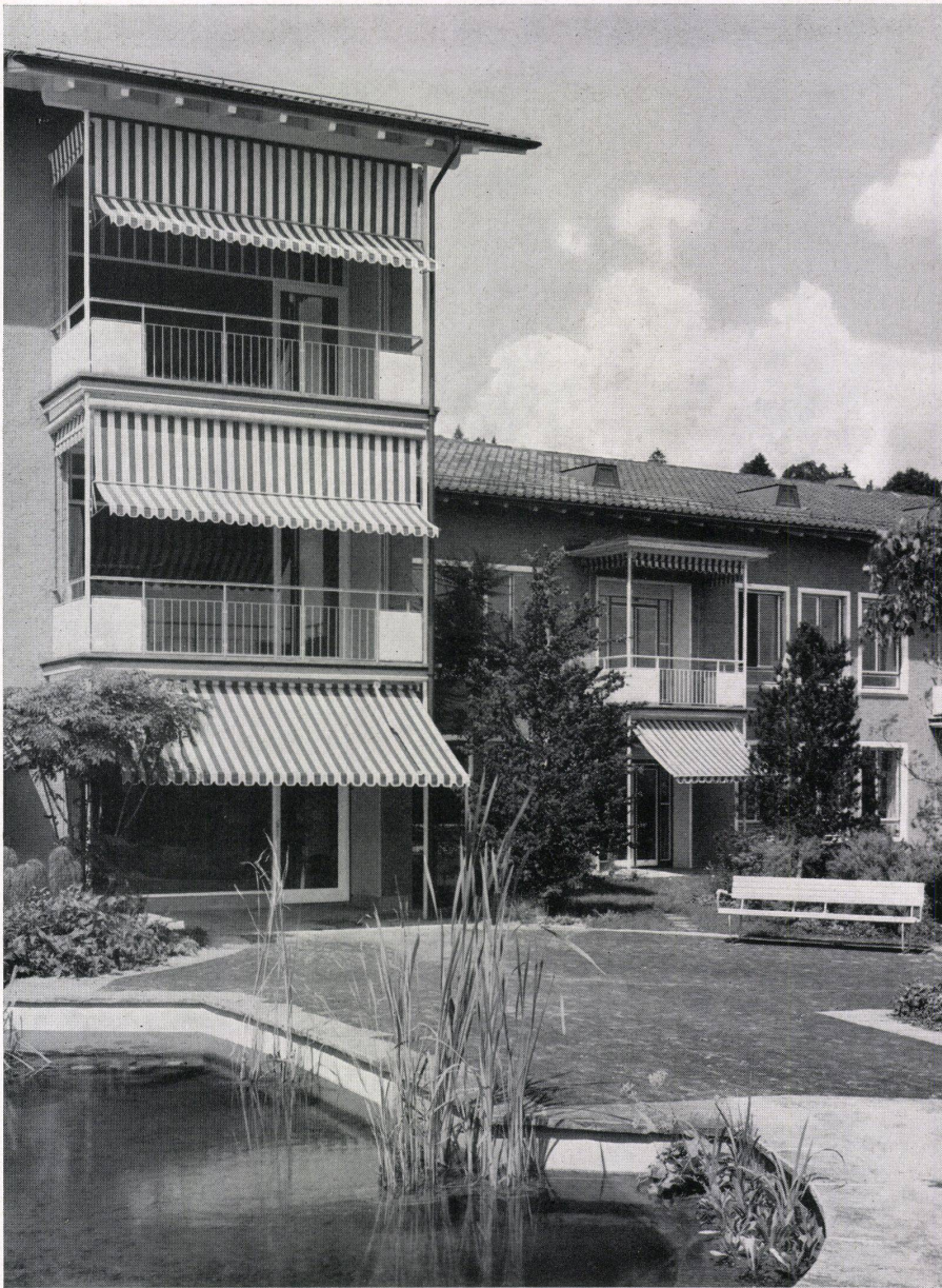
Blick vom Garten auf die Balkone der Tagräume. Vue prise du jardin sur les balcons des salles de séjour. View from the garden looking towards the balconies of the day quarters.
