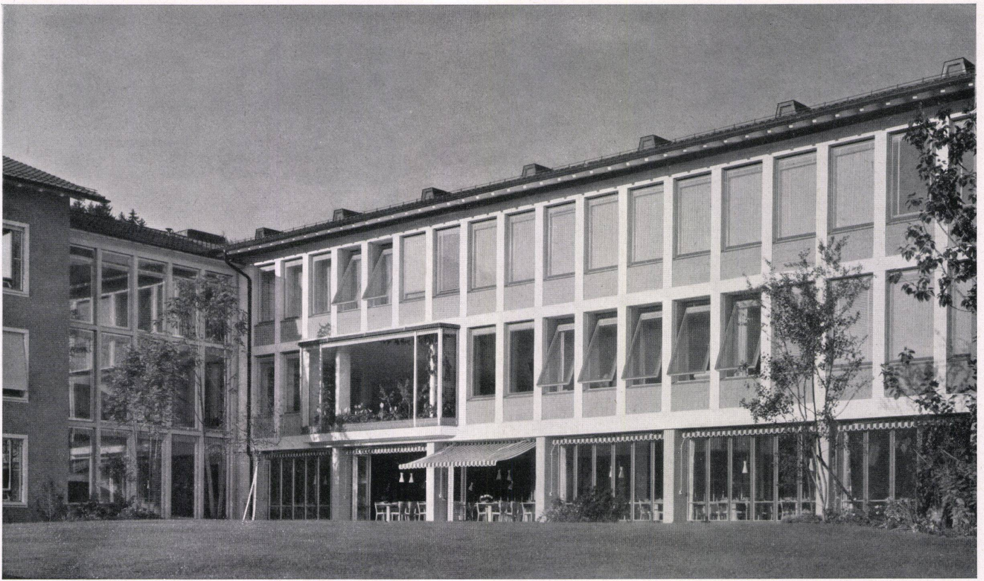
Behandlungsbau H von Westen mit Haupttreppenhaus des Akutspitals A. Pavillon H des traitements vu de l'ouest et cage d'escaliers principale du bâtiment A des maladies graves. Therapy wing H seen from the west, with main staircase of the acute cases ward A.
