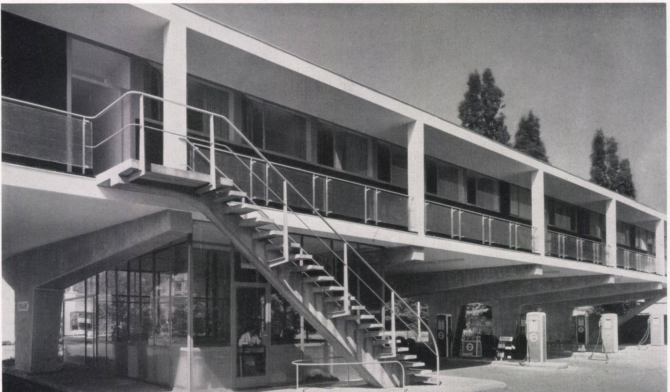
Aufgang zum Personalgebäude mit den Schlafräumen und der Tankwartstelle. Accès au bâtiment du personnel avec ses chambres à coucher et poste à essence. Staircase to the personnel block with the bedroom and the attendant's room.
