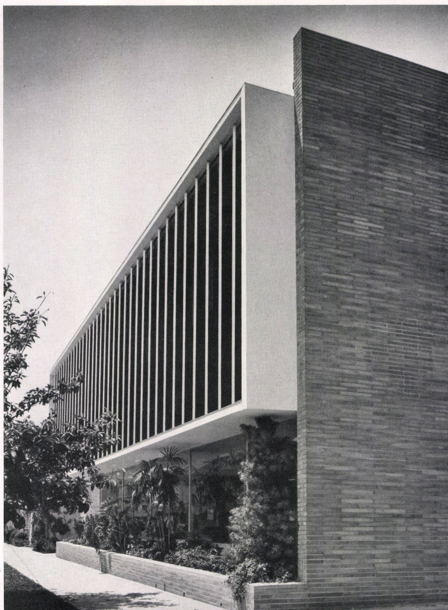
Ansicht der Straßenfassade von Nordosten. Starker Materialgegensatz zwischen Leichtbetonmauern, Sichtbetonteilen und Aluminiumlamellen.
