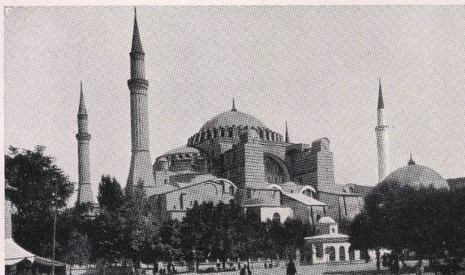
Die Hagia Sofia in Istanbul, ursprünglich als byzantinische Kirche gebaut und später in eine Moschee umgewandelt, ist ursprünglich mit vergoldetem Kupfer bedeckt. Aus dem ersten Jahrtausend stammend bietet sie als eines der ältesten Beispiele kupferbedeckter Dachflächen einen eindeutigen Beweis der Dauerhaftigkeit.
