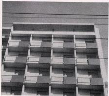
Fassadendetail. Die geschlossenen Geländerplatten sind mit blauem Keramikmosaik belegt. Détail de la façade. Les plaques des balcons sont décorées de mosaïques en céramique bleue.
