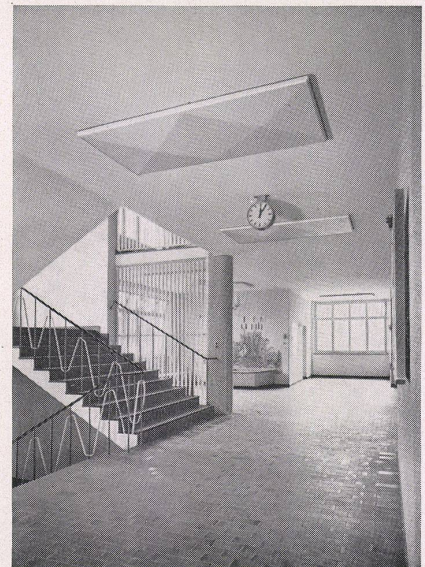
Abb. 3 Treppenhaus mit Decken- Strahlungsheizung
