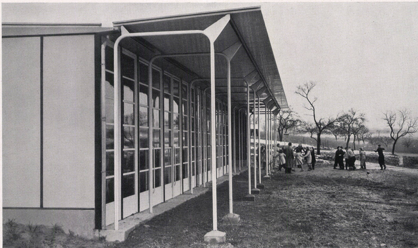
Ansicht der Loggia an der Schule von Vantoux. Elegante U-Elemente tragen das Vordach.
