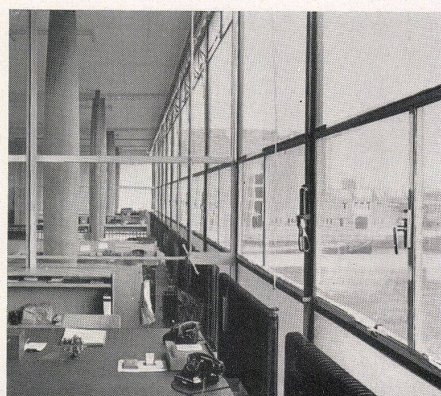
Teilansicht eines großen Büroraums mit den Pendelsäulen. Vue partielle d'un grand bureau à piliers pendules. Part view of a large office with ball-and-socket pillars.
