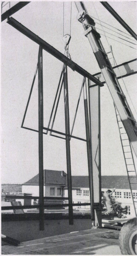
Montage des Glaswandstahlgerippes, das zwischen die Binderpfosten eingestellt wird und zugleich das Fenstersprossensystem bildet. Auch die Binderpfosten sind zugleich Fenstersprossen / Montage de la charpente verre-acier / Assembly of steel framework for glass wall.
