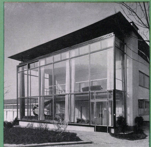
Glas-Fassade in Leichtmetall-Konstruktion
