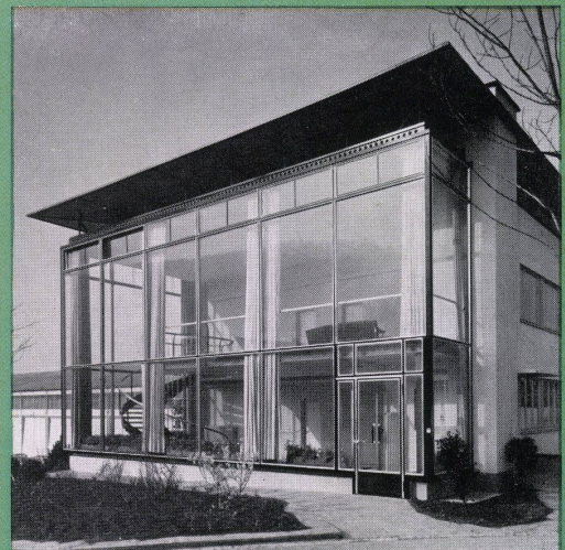
Glas-Fassade in Leichtmetall-Konstruktion
