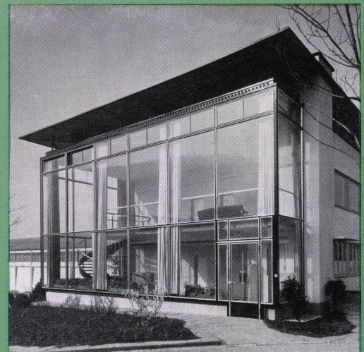
Glas-Fassade in Leichtmetall-Konstruktion
