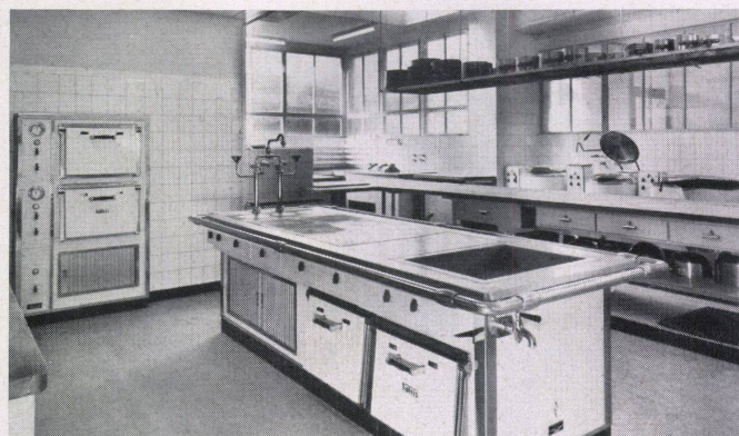
Restaurant Simmenthalerhof, Thun Groß-elektrischer Herd mit Koch- und Wärmeplatten, Wärmeschrank und Backöfen Hintergrund Kippkessel und Bratpfannen Salvis AG., Luzern-Emmenbrücke
