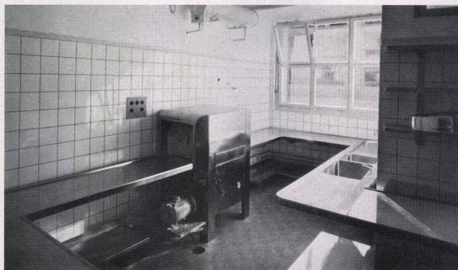
Spülküche mit Geschirrspülmaschine und Chromstahltrögen.
