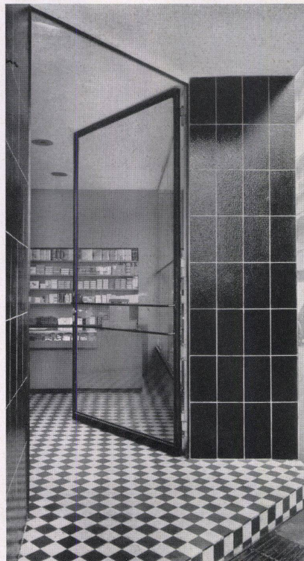
Eingang in den Eckladen. Eingangspfeiler mit schwarzem, genorpeltem Opakglas verkleidet. Fußboden rot-weiße Keramikplatten. Einrichtung des Schokoladen-Ladens mattgrün lackiert.
