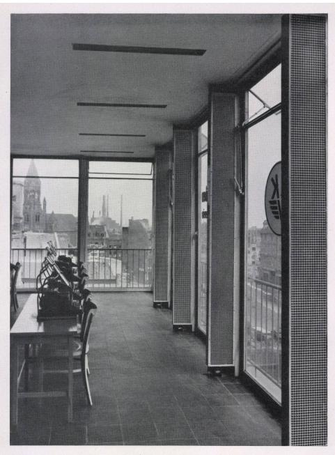
Ansicht eines Büroraumes (Schreibmaschinenschule). An den Fensterpfeilern senkrecht gestellte Hagan-Heizkörper mit gelochtem Blech verkleidet. Fußboden schwarze Hart-Asphalt-Platten. Die in der Decke eingelassenen Beleuchtungsröhren sind in jedem Geschoß beim Bau mit vorgesehen.
