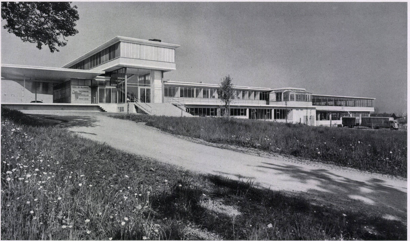
Gesamtansicht der Fabrikanlage von Osten. Vue générale prise de l'est. General view from the east.
