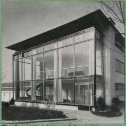
Glas-Fassade in Leichtmetall-Konstruktion
