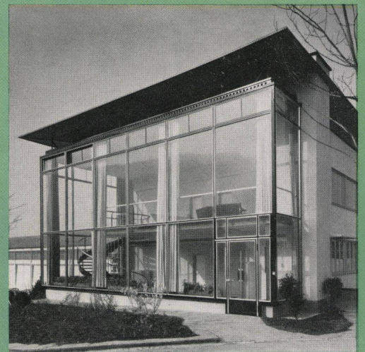
Glas-Fassade in Leichtmetall-Konstruktion
