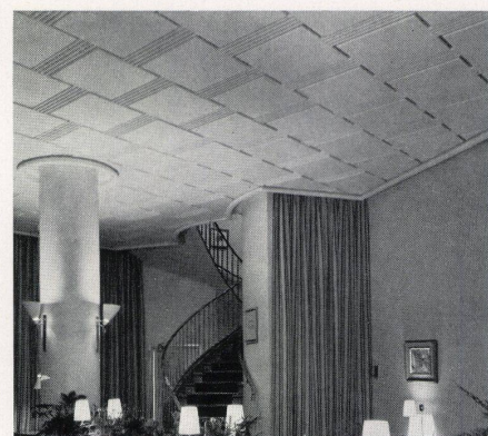
Abb. 9. Café Luxor in Zürich. Architekt A. E. Boßhardt, Zürich. Gelochte «Soundex»-Gipsplatten, 600×600×29 mm, mit Mineralwolle, auf 24 mm Lattenrost, Luftzuführung durch die Platte, siehe Abb. 1, Gesamtfläche 70 m 2 . Ausführung: Isolag, AG. für Isolierungen in Zürich.
