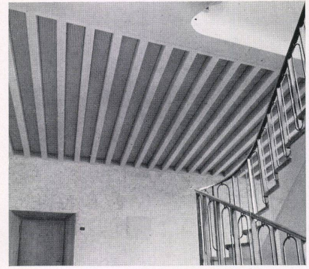
Abb. 4. Töchterschule der Stadt Zürich. Architekt A. C. Müller, Zürich. «Pavatex-Akustik»-Platten, gerillt, 24 mm stark, 15 cm breit, insgesamt 4,5 km. Ausführung: W. Kollbrunner, Isolationen, Zürich.
