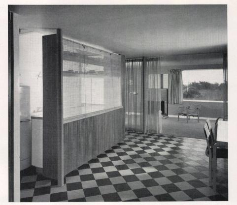
Die Küche mit dem zur Benützung teilweise geöffneten, drehbaren Buffet auf Kugellagern.
