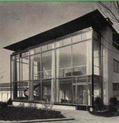
Glas-Fassade in Leichtmetall-Konstruktion
