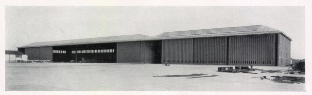
Flugzeughallen Genf-Cointrin (Hangar von 170 m Länge und 62,5 m Tiefe. Werft von 80 m Länge und 42,5 m Tiefe). Projekt und Ausführung der Stahlkonstruktion durch die AG. Conrad Zschokke, Döttingen
