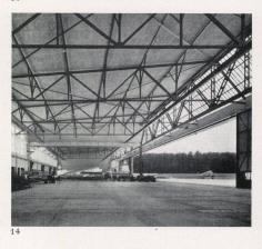
Ciba-Gebäude in Monthey, Stahlskelettbau / Bâtiment Ciba à Monthey; ossature d'acier / Steel skeleton structure
