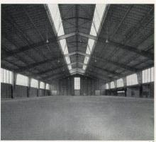
15 Flugzeughangar Cointrin, Genf, Fachwerkkonstruktion / Hangar d'avions à Cointrin, Genève; construction en treillis / Hangar at Cointrin, Geneva. Framework construction
