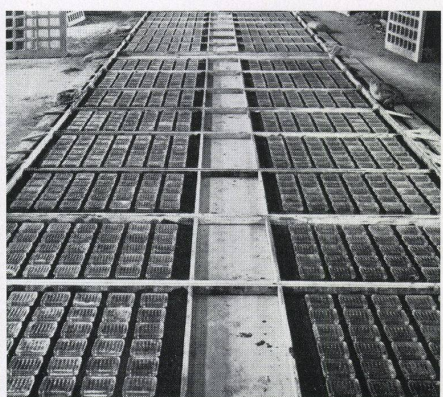
1 Ansicht des Glasbetoneinsatzes des Auslegedaches mit Iperfan-Oberlichtelementen Typ 3050
