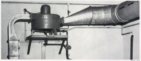
Abb. 12 Klein-Klimaanlage für Tabaklager Sifrag S.A., Bern
