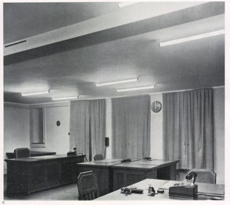
Kaufmännisches Bureau beleuchtet mit Fluoreszenz-Lampen, die auf Montageleisten angebracht sind. Orientierung teils nach dem Einfall des Tageslichtes, teils nach der Lage der Arbeitsplätze. Da es sich um einen ziemlich hohen Raum handelt, darf die offene Anbringung der Lichtquellen hingenommen werden.
