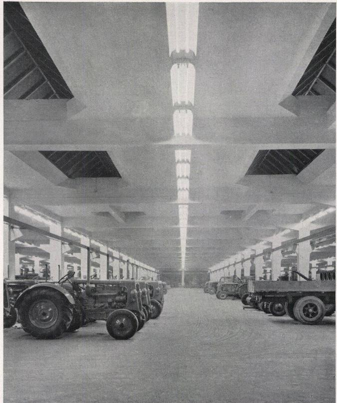
Nachtaufnahme der Montagehalle der Firma Hans Hürlimann, Traktoren- und Motorenwerke, Wil. Doppel-Reflektoren Nr. 2403, bestückt mit 2 Fluoreszenzröhren 40 W, weiß 5500°, Neuwert 200 Lux, direkt an die Unterzüge montiert. Ausführung: Fluora Leuchtstoffröhren G.m.b.H., Herisau.
