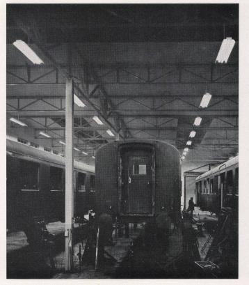
Wagen-Revisionshalle, beleuchtet mit 40 breitstrahlenden Reflektoren für je 2 Fluoreszenz-Lampen 40 Watt, weiß. Mittlere Beleuchtungsstärke zirka 110 Lux. Ausführung: Osram AG., Zürich.
