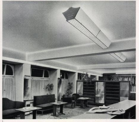
Laden-Beleuchtung mit Fluoreszenz-Lampen: Lichtband an der Fensterfront mit diffusen Gläsern und Rasterleuchten über den Verkaufstischen. Philips Lampen AG., Zürich
