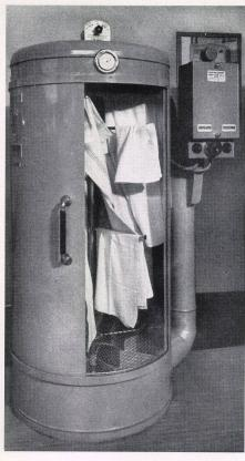
Automatischer Wäschetrockner für Wohnkolonien. Der Trockenvorgang entspricht weitgehend demjenigen im Freien. Viel Luft, nicht zuviel Wärme. Die Wäsche wird weich und saugfähig. A. von Rotz, Ingenieur, Basel
