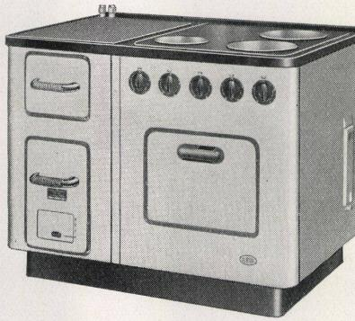
Kombinierter Haushaltherd SURSEE Typ 405 Z bestehend aus Elektroabteil und einem Feuerungsabteil mit eingebautem Heizkessel für eine Zentralheizung einer Etagenwohnung oder eines kleineren Einfamilienhauses. Zusätzlich kann eine Heizschlange für Boiler eingebaut werden, so daß der Herd gleichzeitig zum Kochen, Heizen und zur Warmwasserzubereitung dient.
